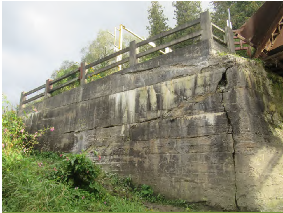
Photo P3 NE Wingwall
