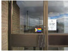
2 UWY - entrance door
